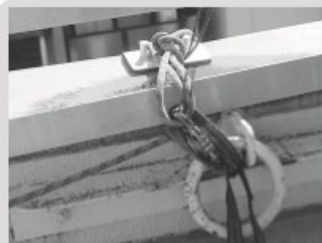
ロープの設置近影。1本のロープの緊結具としカラビナを使用し、もう1本のロープの引き寄せも同じカラビナを使用し、×。設置方法は指導事項、参照。
