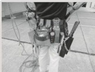
安全帯は胴ベルト型1本吊り用を着用しているが、D環を取り外して改造。さらに、墜落阻止器具がなしで、×&×。
